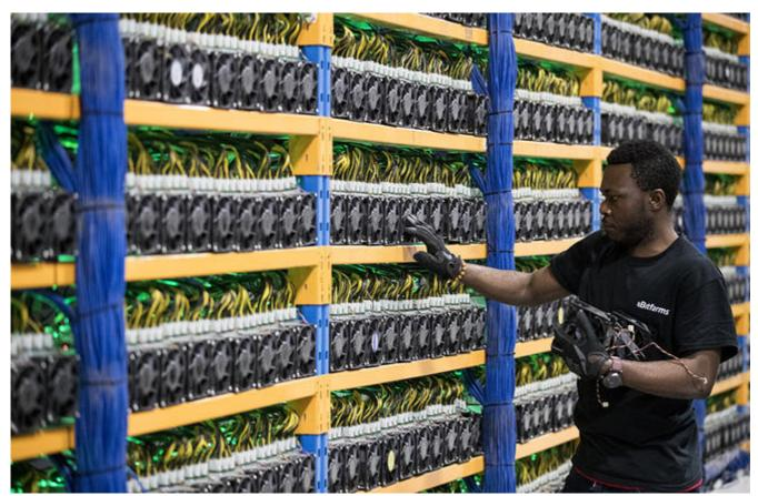
A l'intérieur d'une ferme de minage située au Canada. Les fermes de minage sont des sortes de data center dédiés aux calculs permettant de générer (miner) les cryptomonnaies.
